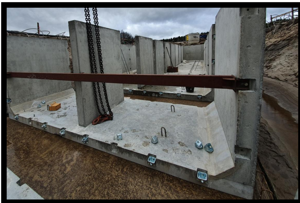
Zdj. 4a. – powierzchnia osuszona.
